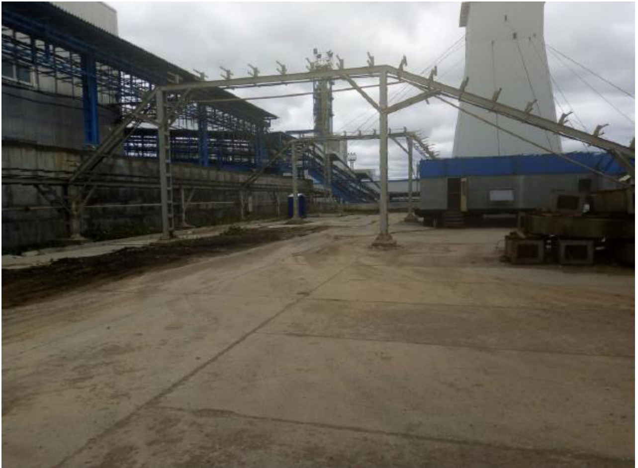
Рисунок 6.2 – Территория промышленной площадки Усольского калийного комбината (в районе ствола № 3)
