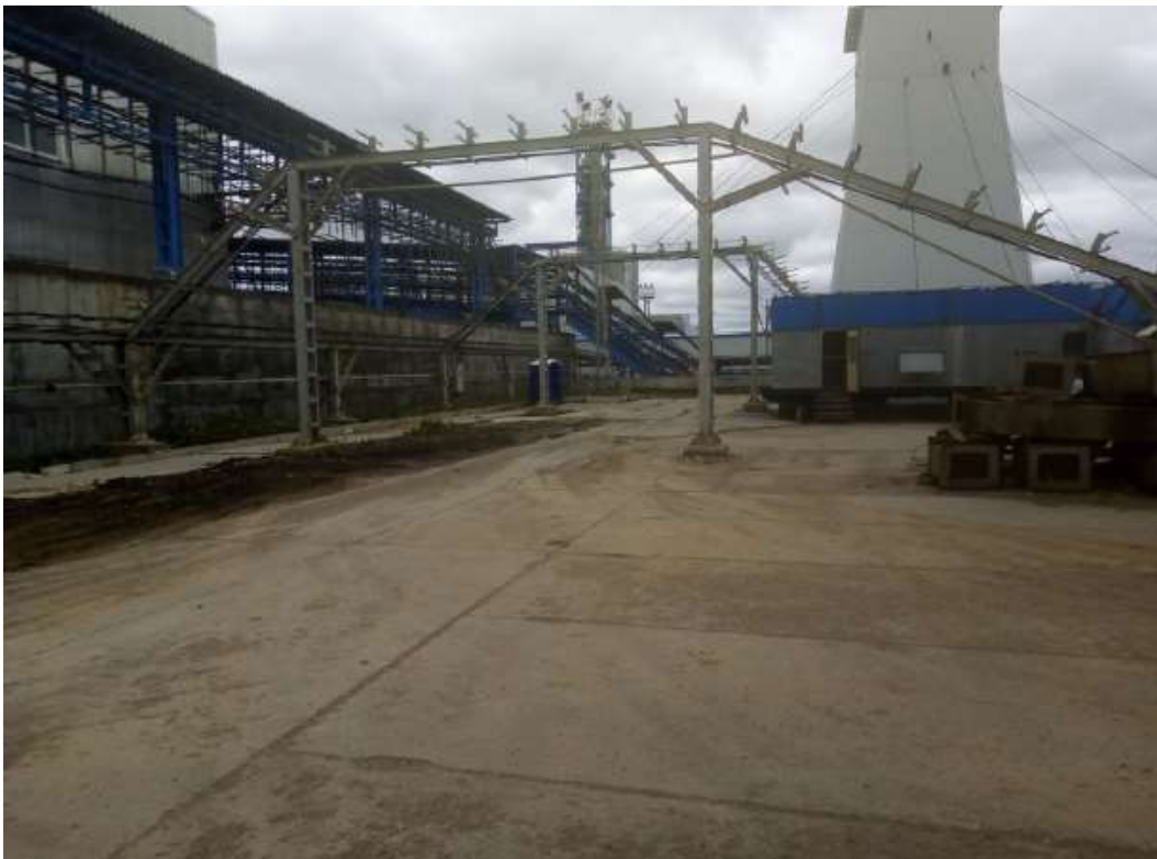
Рисунок 6.3 – Территория промышленной площадки Усольского калийного комбината (в районе ствола № 3)
